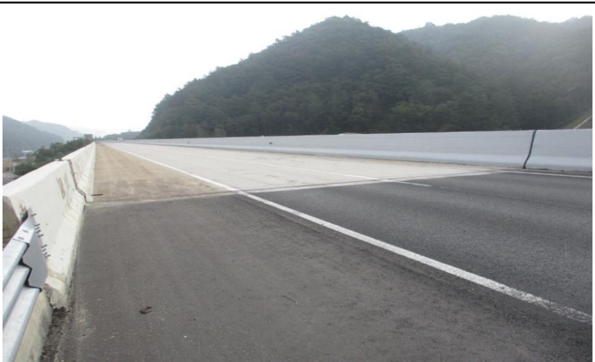
교량 상부 전경
