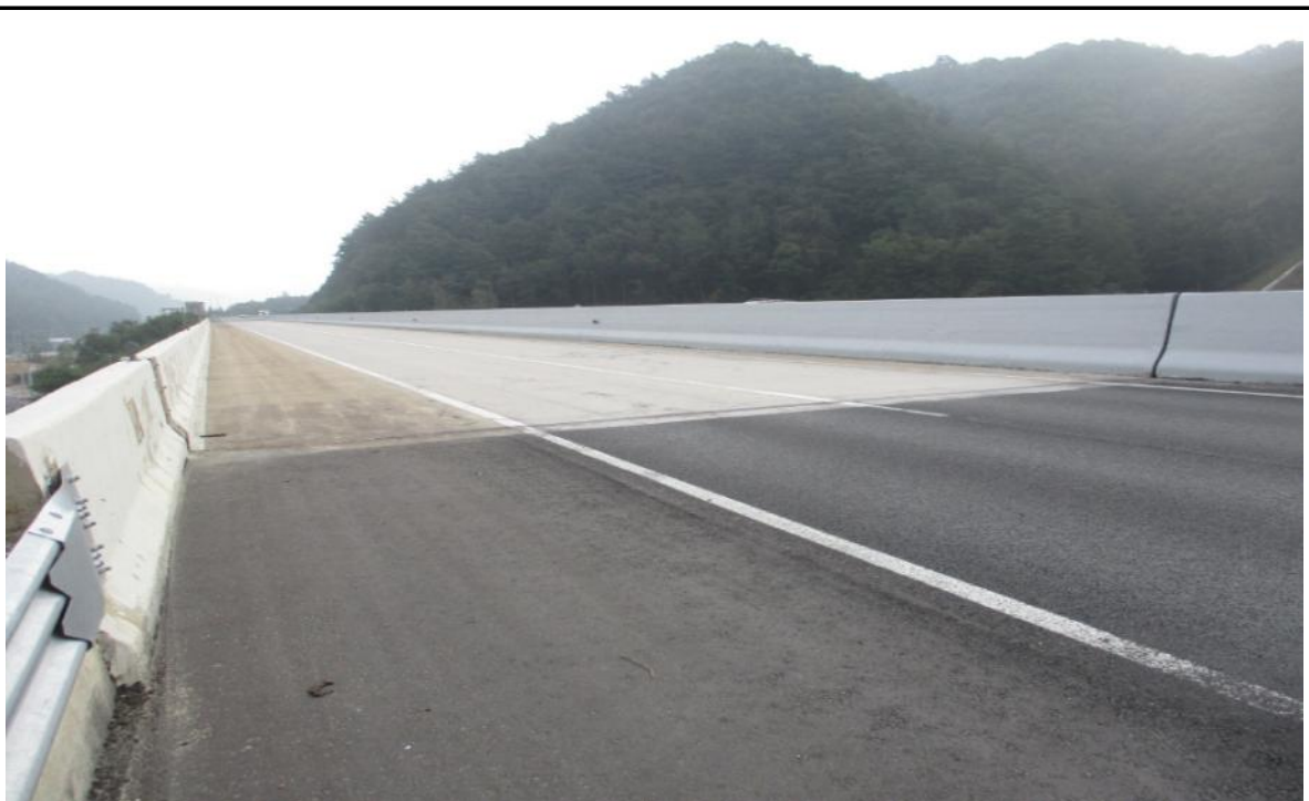
교량 상부 전경
